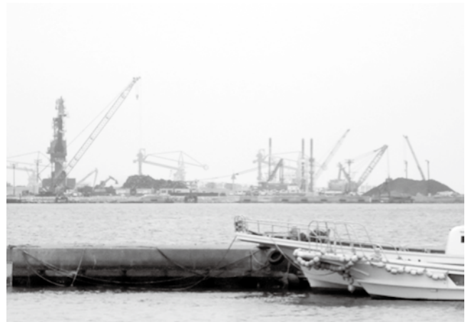
相馬港の復興工事の風景
